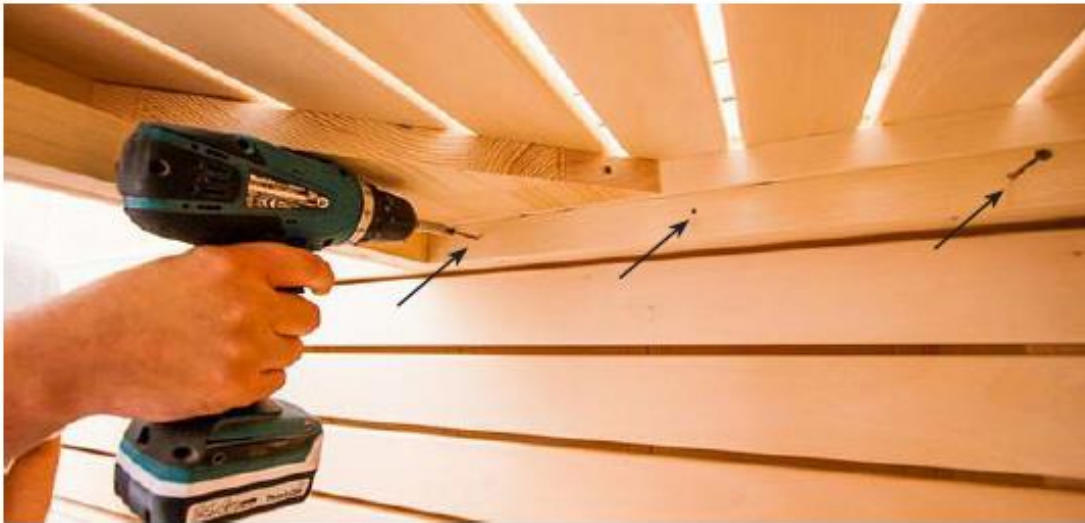
Burghiu de 3 mm, 3 șuruburi 5 x 70 mm
