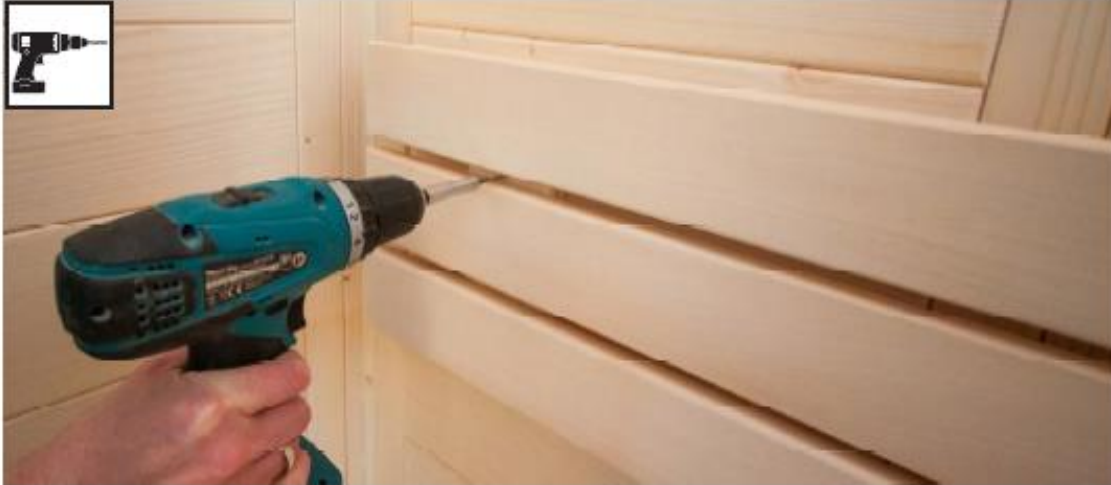
Burghiu de 3 mm, 3 șuruburi 3 x 40 mm
