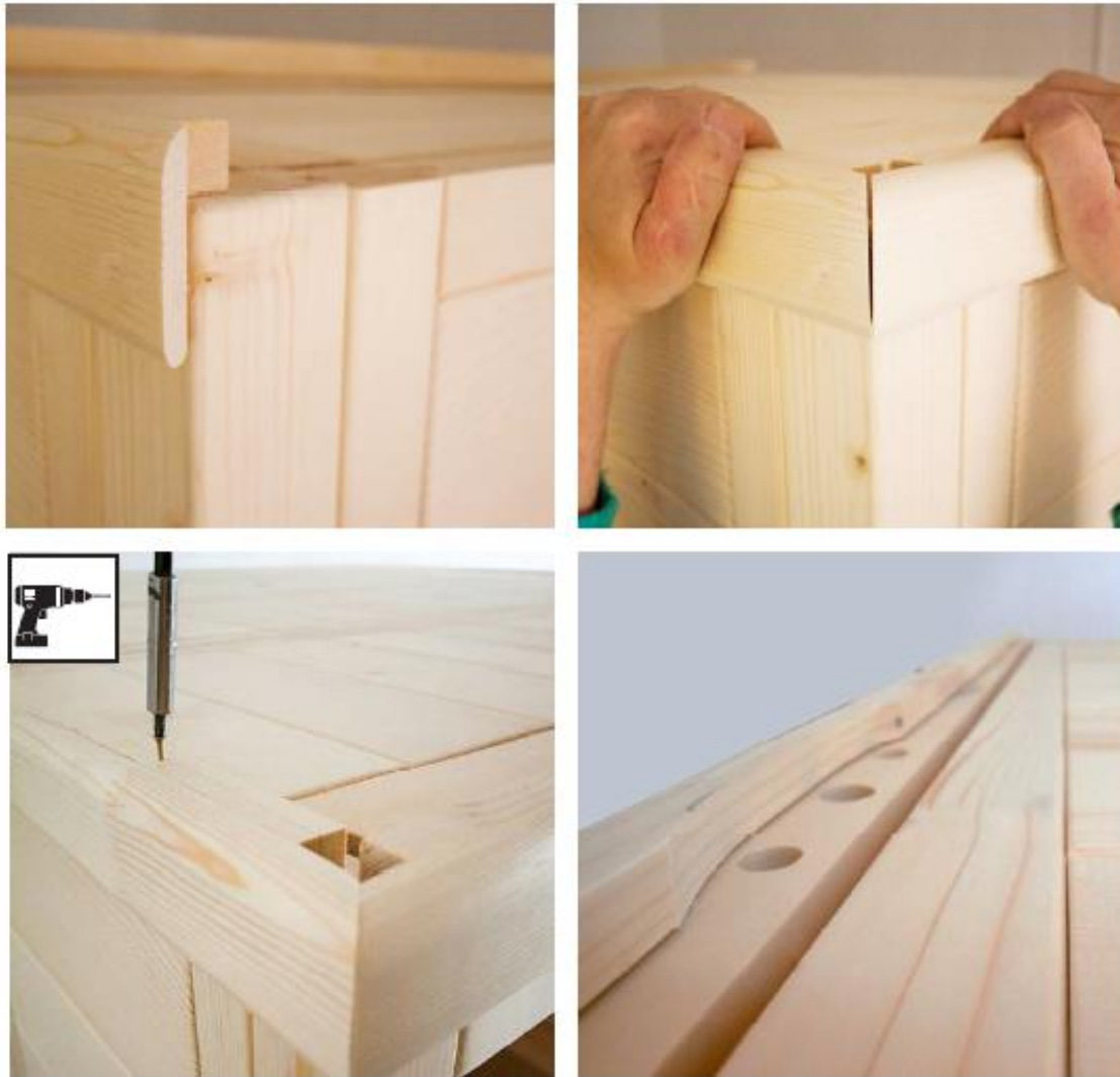
Burghiu de 3 mm, 9 șuruburi 3 x 40 mm
