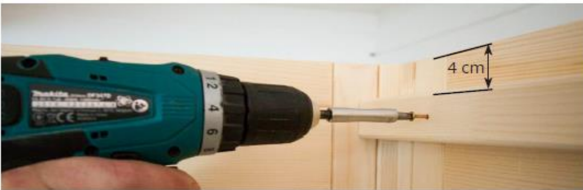
Burghiu de 3 mm, 16 șuruburi 4 x 70 mm
