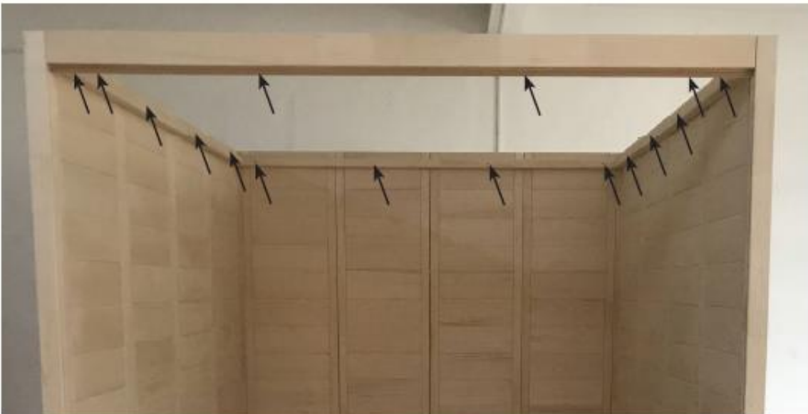
Burghiu de 3 mm, 16 șuruburi 4 x 70 mm
